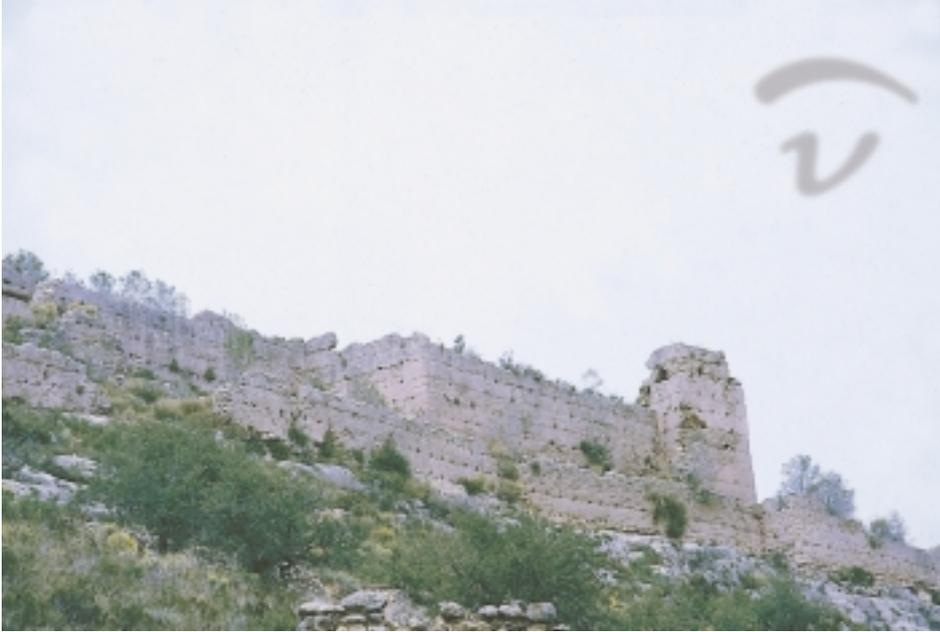
*Foto 249. Xio. Han desaparecido, o quedan escasos restos de las distintas maderas que transversalmente se colocaban para cerrar los cajones. Por ello se aprecian una serie de agujeros allí donde fueron colocadas.*
