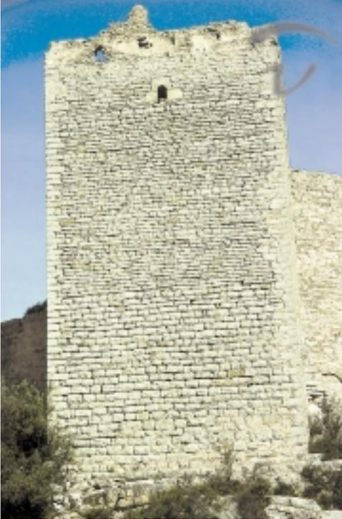
*Foto 277. Polpís. Véase cómo en la construcción de la cara de esta torre se han utilizado diferentes tamaños de piedras. Éstas se agrupaban en hiladas para así ascender progresivamente e igualar todos los lados y aparejo.*
