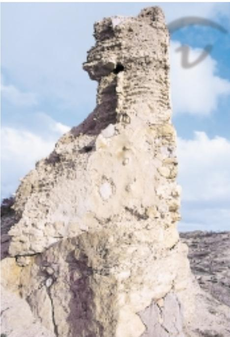
*Foto 246. Busot.* Las esquinas de los encofrados eran reforzadas con mortero, quedando así una especie de “aguja” que aún mantiene la parte inferior de aquella muralla o lienzo.
