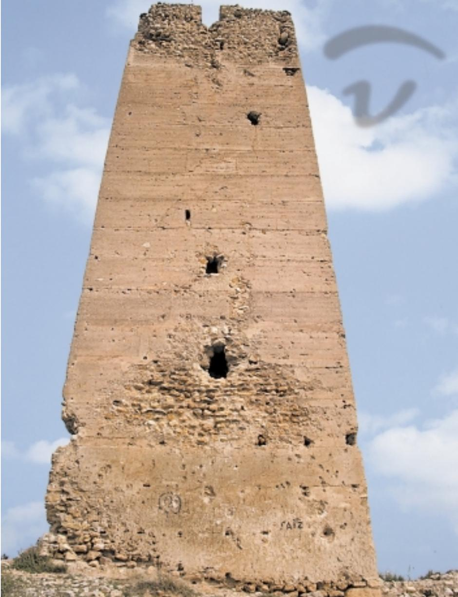
Foto 251. Bofilla. También se puede distinguir esa ordenación del material en las partes superior e inferior de la torre de Bofilla. Para ver estos detalles es necesario que haya desaparecido la costra de cal que cerraba los encofrados.
