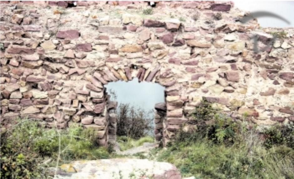
*Foto 264. Castro de Fondegulla. Con lajas de rodano se enmarcaban las puertas o arcos de entrada.*
