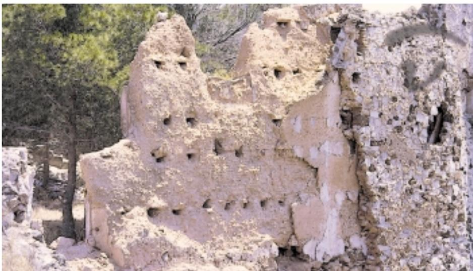
*Foto 240. Cofrentes. La costra de cal exterior tenía la finalidad de conservar en buen estado aquel elemento. A veces, cuando faltaba se volvía a colocar y cerrar. Se puede constatar en la nueva cubierta que se realizó en Cofrentes.*
