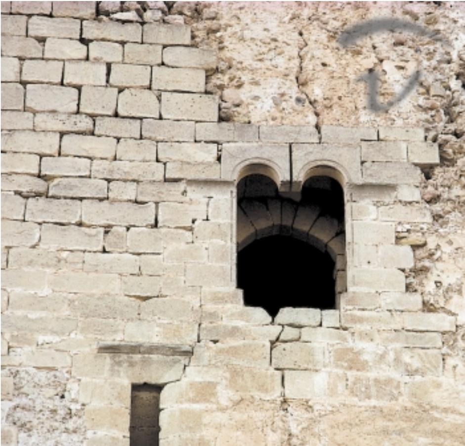
*Foto 274. Cocentaina. Realizada la construcción con tapial o mampostería, posteriormente se revistió con una capa de piedras que a forma de sillares cerraba una parte de su conjunto.*
