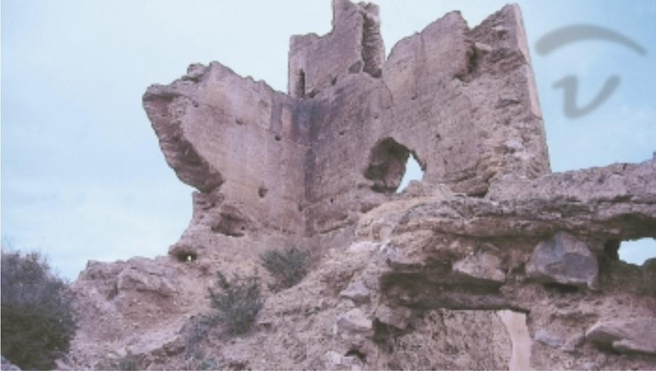
*Foto 245. Orihuela.* Si la costra era bastante compacta y se rompía por su parte inferior, era normal que la tierra del interior desapareciera y se conservara sólo parte de la estructura exterior.
