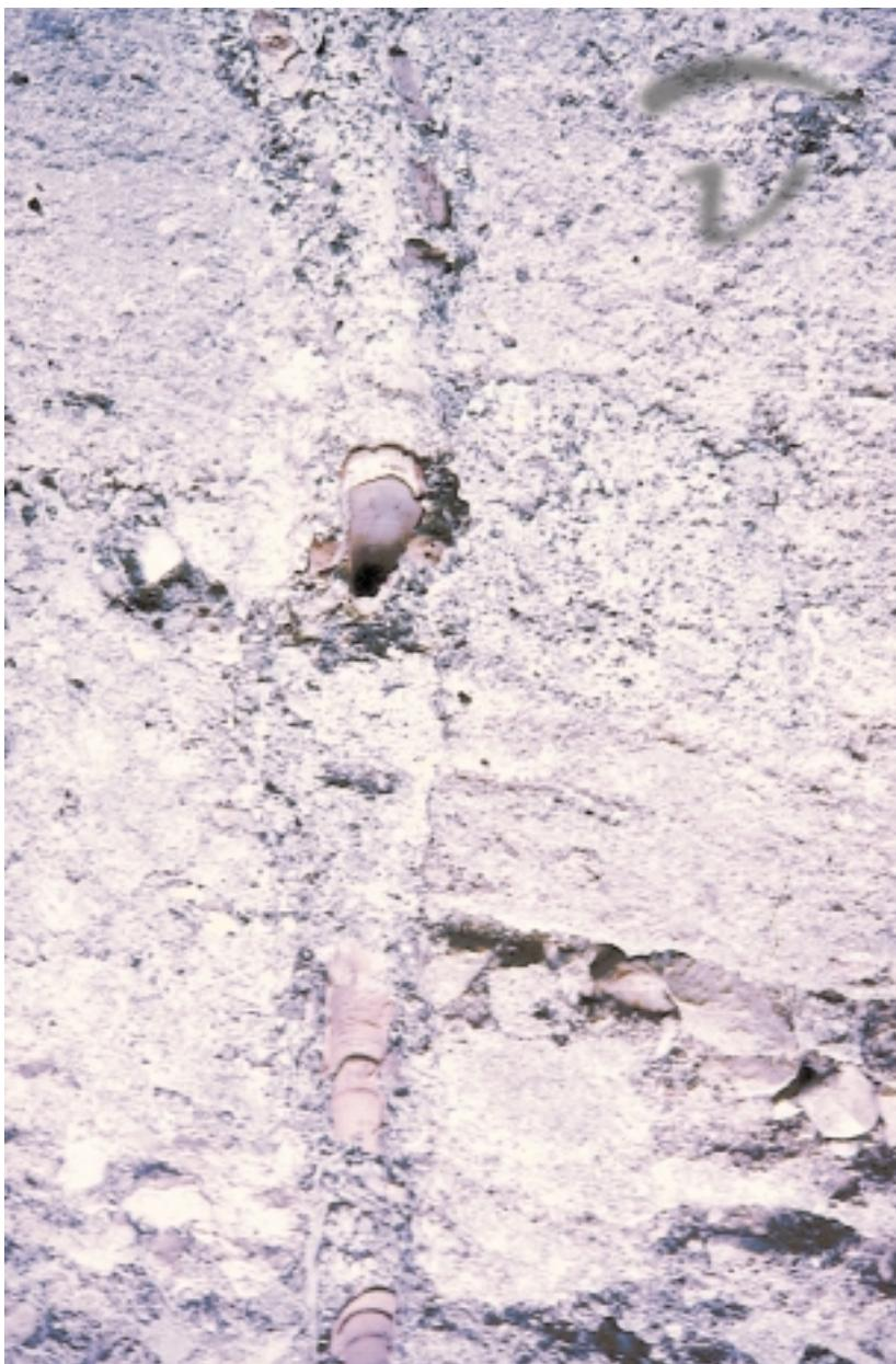
Foto 273. **Perputxent.** La conducció del aigua de la cuberta o parte superior a la inferior -aljibe o desagüe- se realitzava per mitjà de conductes de alfareria.
